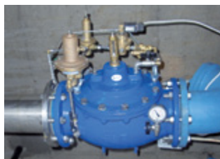
valvola di controllo della pressione
